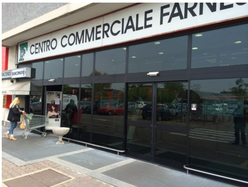
Porta automatica installata presso il Centro Commerciale Farnese
