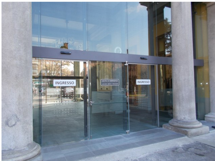
Porta scorrevole automatica installata presso l'ospedale di Piacenza
